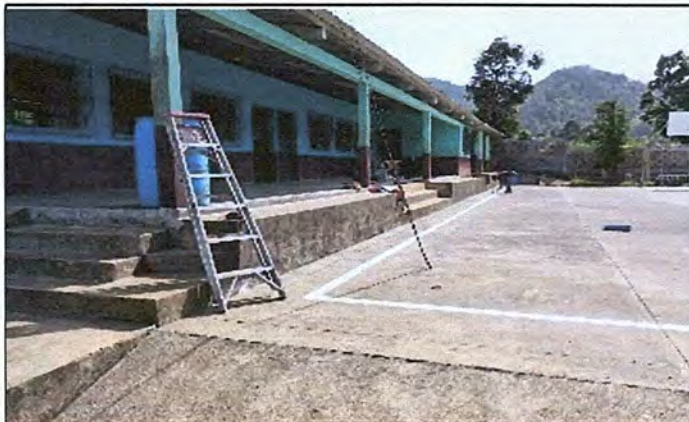
Foto 2: PINTURA DE CANCHA POLIDEPORTIVA
